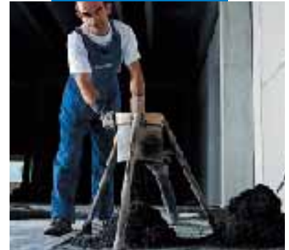
Batching a Mapecem mix
